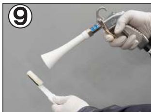
⑨ エアブロー 液を塗布する前に、エアブロー等でウレタンシートと施工面のホコリを取り除きます。
