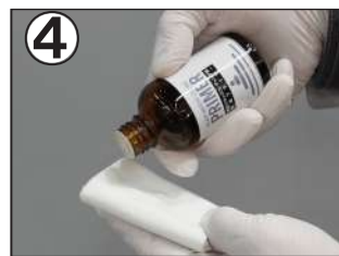
④ プライマー塗布 塗り込み専用クロスに、専用プライマーを垂れない程度塗布します。
