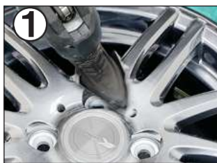
① 下処理 事前に施工面の汚れやキズを状態に応じて洗浄および研磨で除去しておきます。
